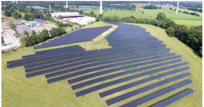
PV-Anlage auf der Deponie Flamschen mit einer installierten Leistung von 1.830 kWp (Quelle: GFC)
