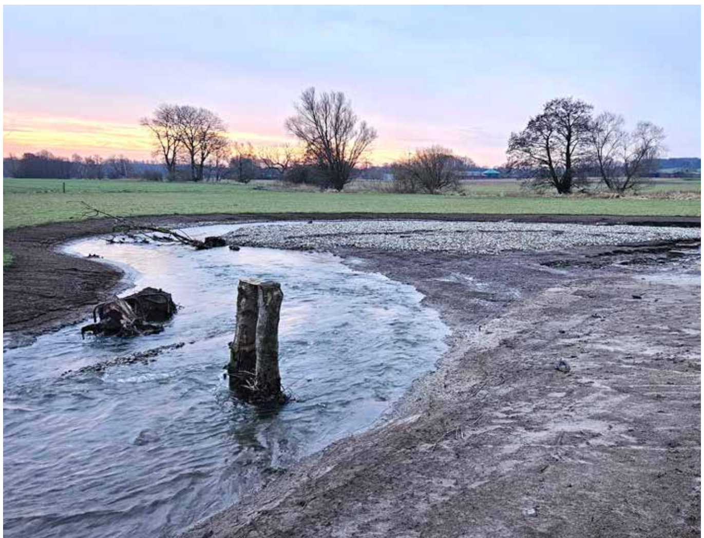
Aufweitung des Bachbettes mit Kiesablagerung (Foto: WBC)
