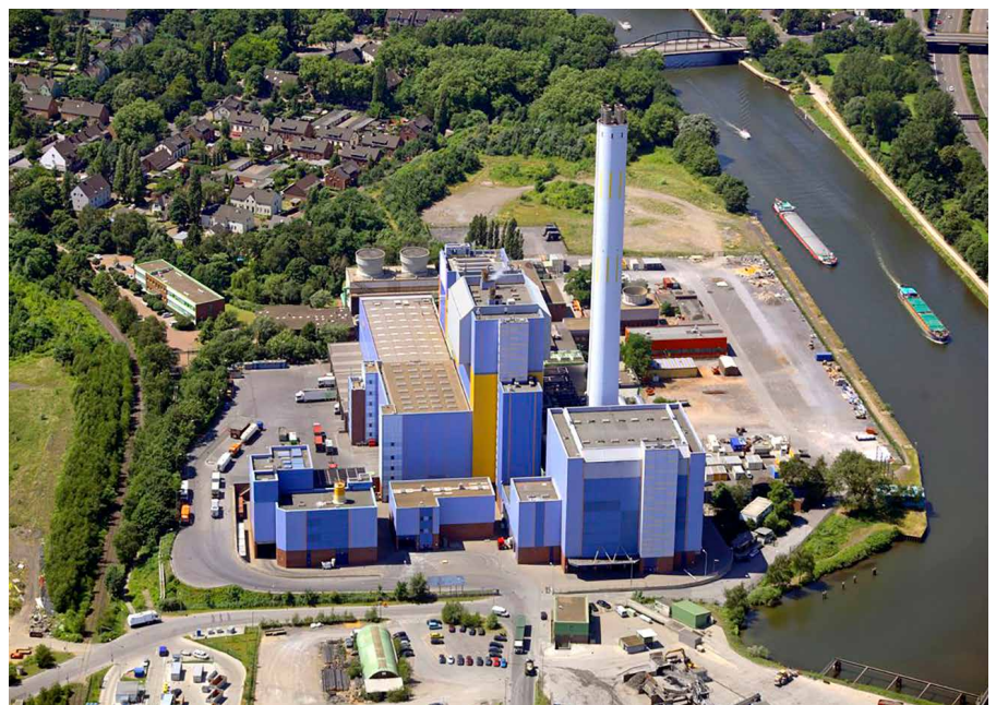
In der als öffentlich-private Partnerschaft (ÖPP) betriebenen GMVA werden jährlich bis zu 700.000 t Abfälle thermisch behandelt. Modernste Rauchgasreinigungssysteme sollen garantieren, dass über den Kamin nahezu reine Luft an die Umwelt abgegeben wird.
