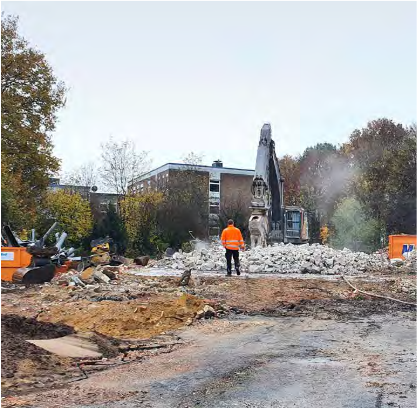
Am 04.10.2022 war es soweit. Das beauftragte Unternehmen konnte im ersten Schritt mit der Baustelleneinrichtung beginnen. Im Laufe der zehn wöchigen Abbruchphase wurden so ca. 3.000 Tonnen Material mit ca. 120 LKW-Ladungen abgefahren.
