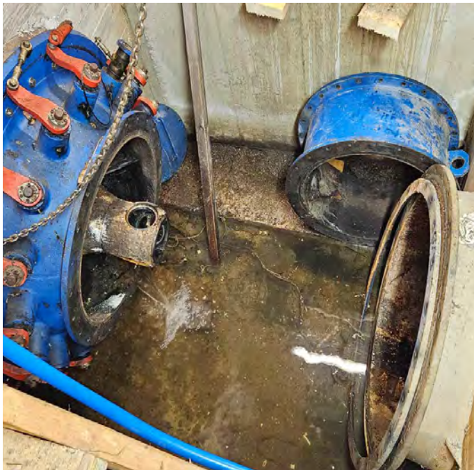
Revision der Wasserturbine (Foto: GFC)
